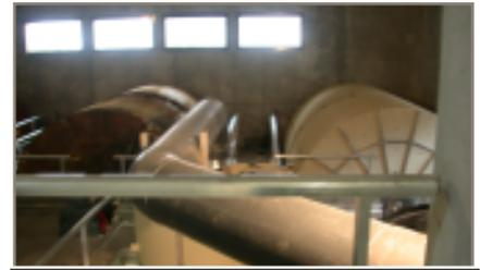
3 immenses BIODISQUES, constitués de lamelles synthétiques, sont chargés de bactéries qui assurent les traitements suivants. Les boues s'agglomèrent avant l'arrivée au décanteur secondaire.
