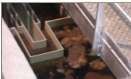
Voici le DECANTEUR SECONDAIRE: les eaux passées par les biodisques arrivent ici. Les boues sont extraites et les eaux repartent à la Dranse.
