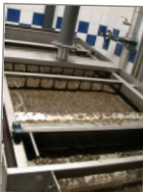
Les boues partent dans une bache sous la table d'égouttage. Un polymère finit de séparer les boues et l'eau sur la table d'égouttage. Les boues partent dans le silo de stockage après un traitement au lait de chaux.
